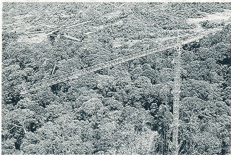
ボルネオ島の熱帯林を観測するために建設されたクレーン(熊谷朝臣さん提供)
